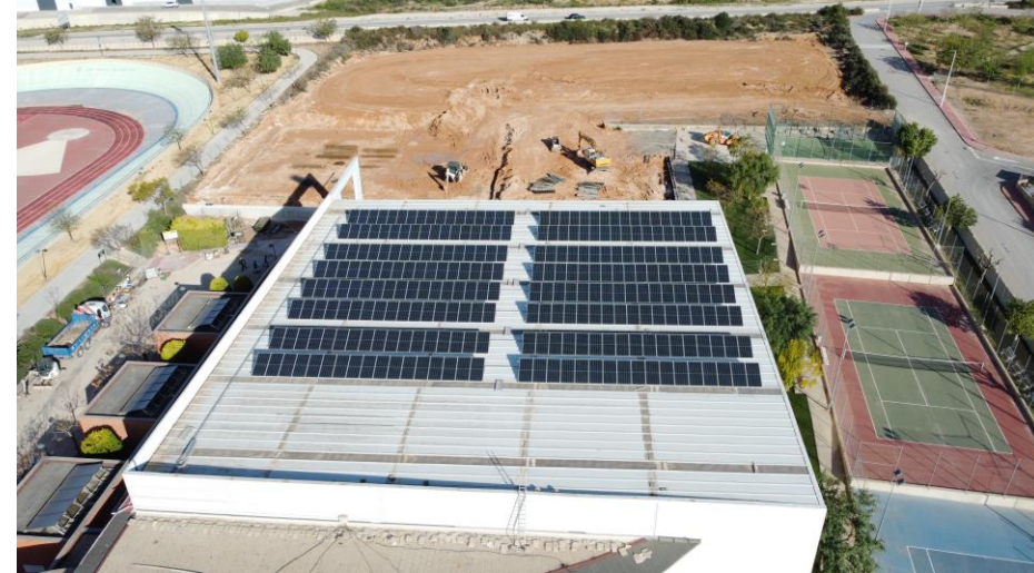
Polideportivo Félix Candela (cubierta) (120 kW)
